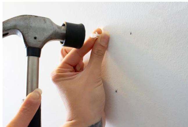
2 In die Bohrlöcher die Befestigungs-Dübel mit einem Hammer bündig einschlagen.
