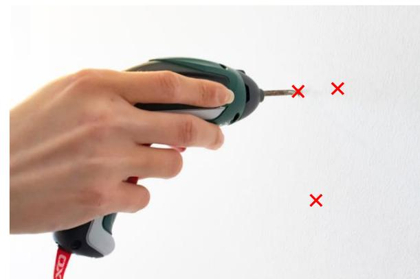
1 Befestigungslöcher anzeichnen und bohren
